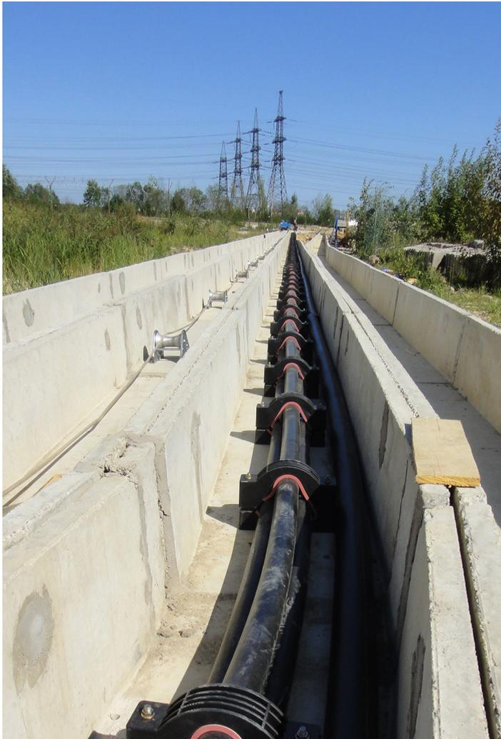
Bei der Verlegung von VPE-isolierten Kabeln mit der Spannung von 66-220 kV muss der Biegeradius mindestens  $20 \times D$  sein, wobei  $D$  der Außendurchmesser des Kabels ist. Nach erfolgter Verlegung der Kabel ist eine Biegung mit dem Radius von  $15 \times D$  unter der Voraussetzung zulässig, dass eine spezielle Schablone verwendet wird (beispielsweise an den Endverschlüssen).
