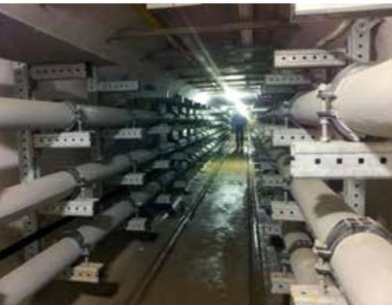
**Рис. 1.** Крепление кабелей 500 кВ в плоскости на консолях в коллекторе КВЛ 500 кВ «Западная – Очаково», г. Москва, 2012 г.
