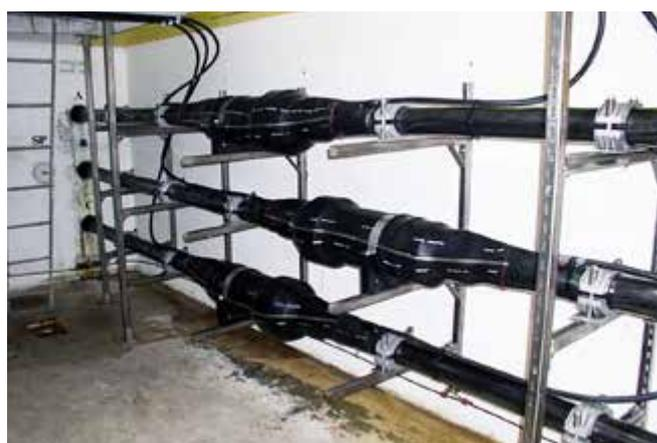
**Рис. 8.** Крепление кабелей 220 кВ с двух сторон от соединительных транспозиционных муфт CFJX-245 фирмы Prysmian (Голландия), закреплённых на консолях
