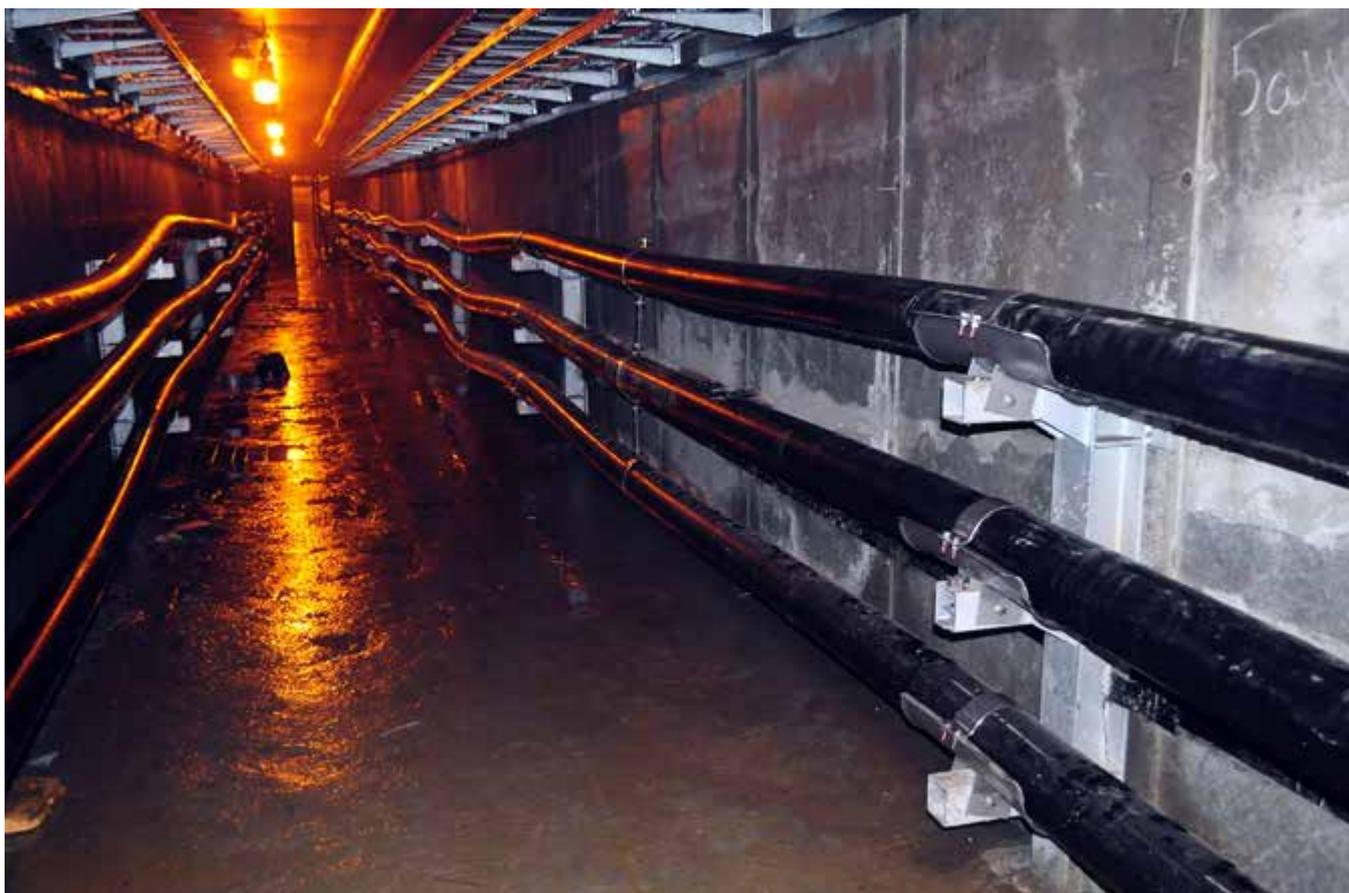
Рис. 22. Крепление кабелей 500 кВ в тоннеле на Богучанской ГЭС
