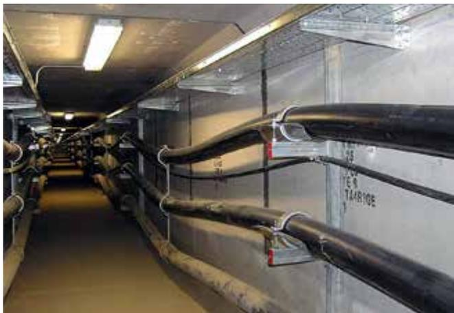
**Рис. 12.** Кабели 220 кВ, закреплённые в плоскости на консолях с помощью сёдел, жёстко закреплённых на консолях
