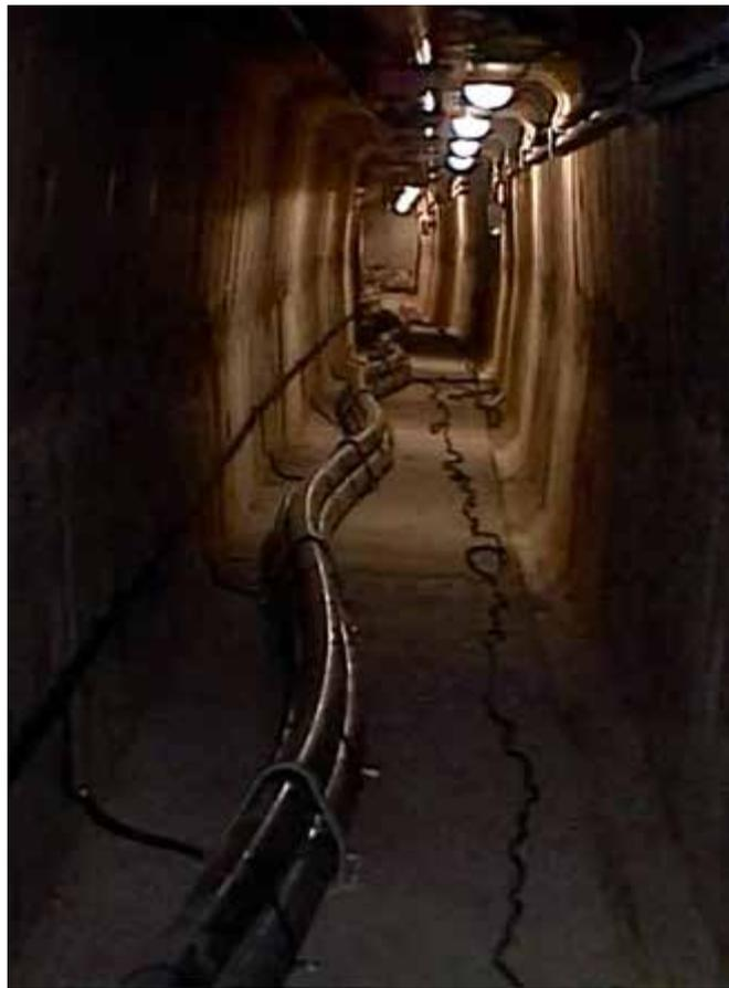
Рис. 21. Прокладка кабелей в лотках в тоннеле между КРУЭ и шахтой 115 м с изгибом в горизонтальной плоскости
