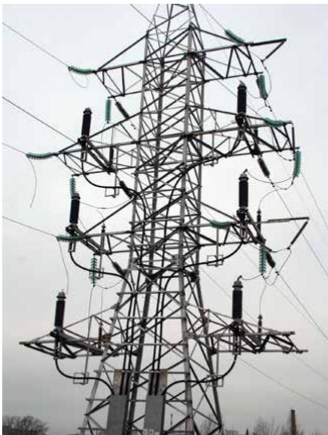
**Рис. 5.** Крепление кабелей 110 кВ на опоре ВЛ со смонтированными концевыми муфтами АРЕСВ 1452 фирмы АВВ Kabeldon (Швеция), г. Казань, 2008 г.
