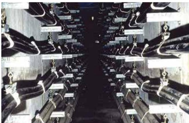
**Рис. 14.** Крепление кабелей хомутами, с подвешиванием хомутов на консолях
