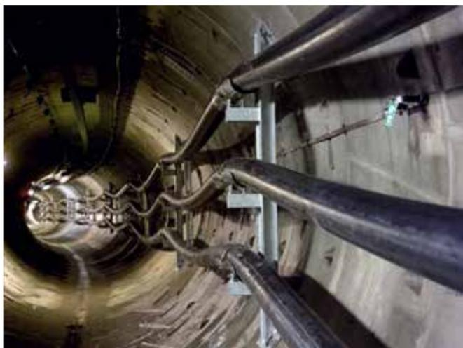
**Рис. 13.** Кабели на напряжение  $U_m = 420$  кВ, закреплённые в плоскости на консолях с помощью сёдел, шарнирно закреплённых на консолях
