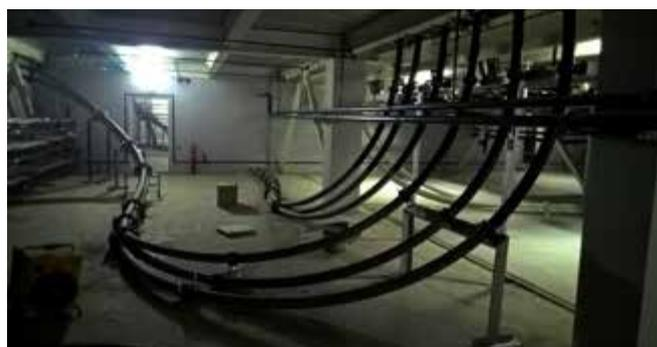
**Рис. 7.** Крепление кабелей 220 кВ в подвале КРУЭ 220 кВ. ПС 220 кВ «Мангазея», Ямало-Ненецкий АО, 2016 г.
