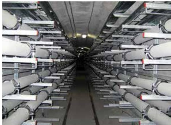
**Рис. 3.** Крепление кабелей 220 кВ, расположенных на консолях треугольником с разнесением
