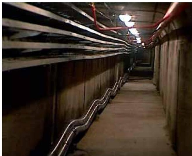
**Рис. 19.** Фото тоннеля 410 с кабелями 500 кВ, закреплёнными на сёдлах «Эллис»
