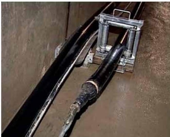
**Рис. 16.** Прокладка кабеля 500 кВ в тоннеле 410 м с помощью 4-сторонних роликов, закреплённых на консолях
