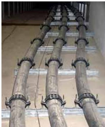
**Рис. 2.** Крепление кабелей 220 кВ в плоскости на подставках, закреплённых на полу
