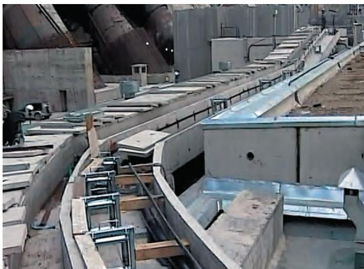
*Рис. 7. Прокладка кабелей 500 кВ на повороте трассы в лотках на плотине*
