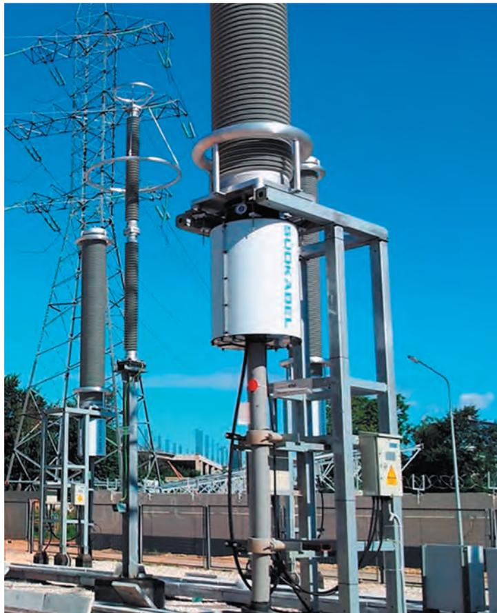
*Рис. 9. Концевая муфта EHFVCS 550 F с системой обогрева, электроконтактным манометром и присоединительным ящиком О.ЕК-LS1*
