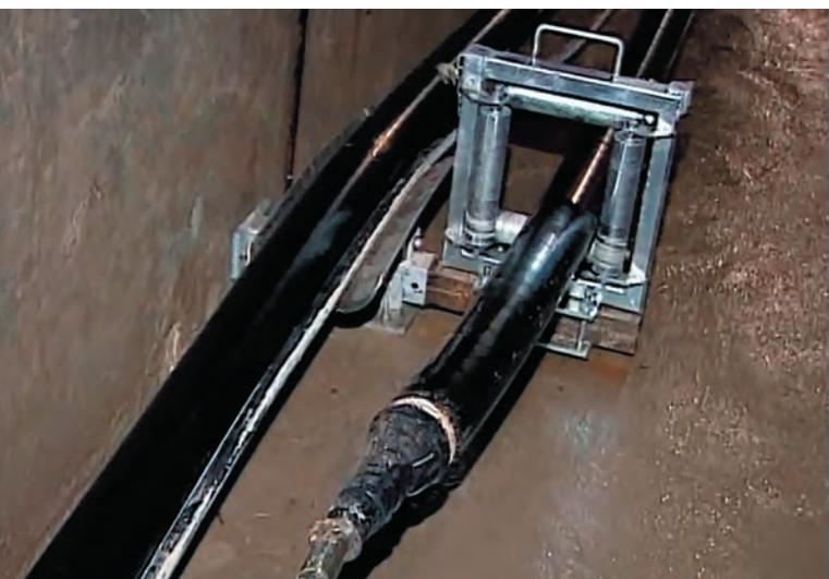
*Рис. 5. Прокладка кабелей 500 кВ в наклонном тоннеле 410 м*
