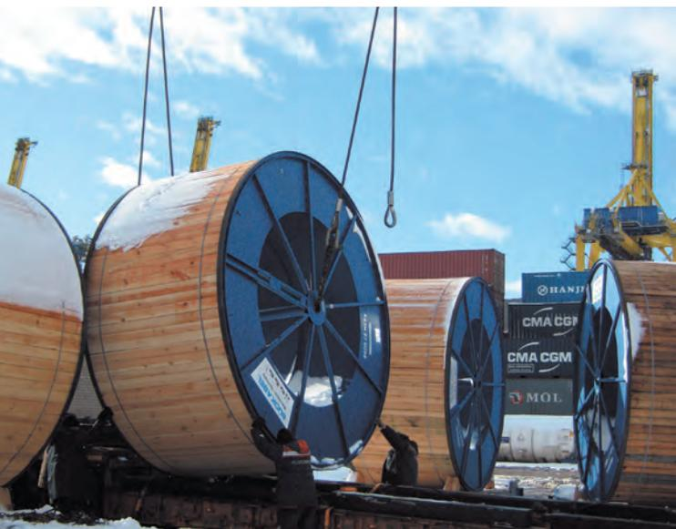
Рис. 13. Погрузка барабанов с кабелем 500 кВ в порту на автомобильный прицеп
