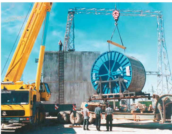
*Рис. 2. Разгрузка барабана с кабелем 500 кВ, закреплённого на транспортировочной металлоконструкции*
