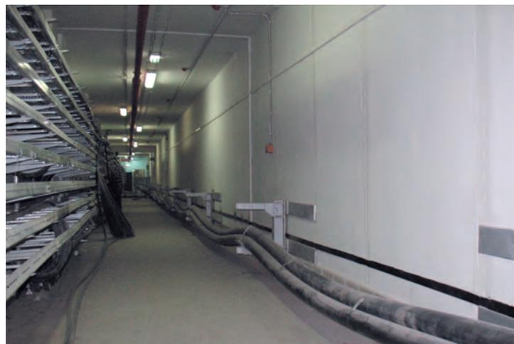
Рис. 16. Кабели 500 кВ с медной жилой сечением 800 мм<sup>2</sup> в тоннеле на Богучанской ГЭС
