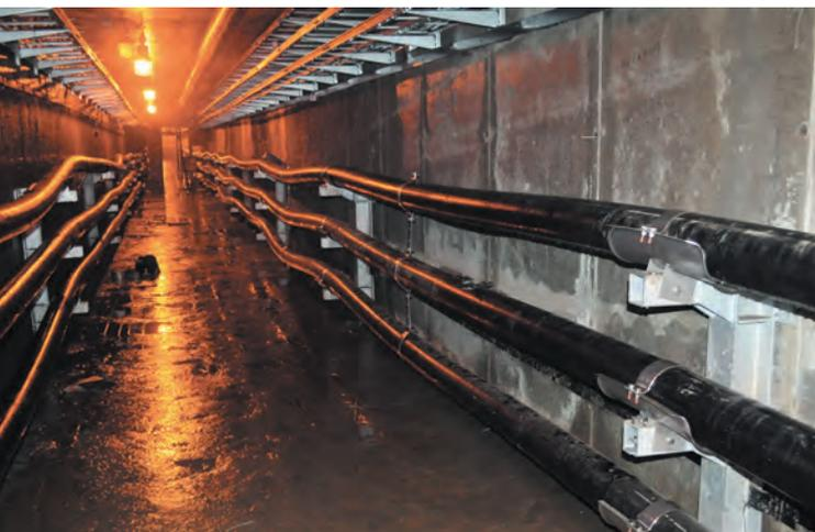
Рис. 15. Кабели 500 кВ с медной жилой сечением 2500 мм<sup>2</sup> в тоннеле на Богучанской ГЭС
