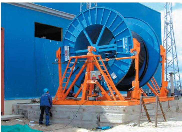
*Рис. 3. Барабан с кабелем 500 кВ на отдающем устройстве у стены помещения КРУЭ 500 кВ на отметке 292 м*
