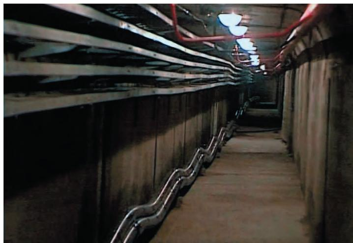
*Рис. 6. Наклонный тоннель 410 м с кабелями, закреплёнными на сёдлах фирмы ELLIS*
