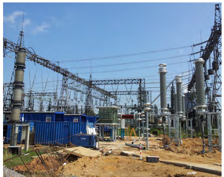
Рис. 34. Испытания всей кабельной линии на первом этапе строительства
