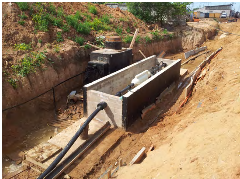
Рис. 31. Колодец М20 А с одной ремонтной соединительной муфтой SEHDVCB 550 до засыпки
