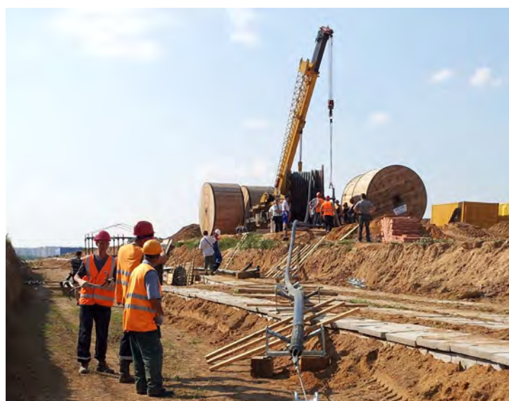
Рис. 21. Спуск кабеля 500 кВ по роликам с барабана, расположенном на отдающем устройстве, на трассу кабельной линии
