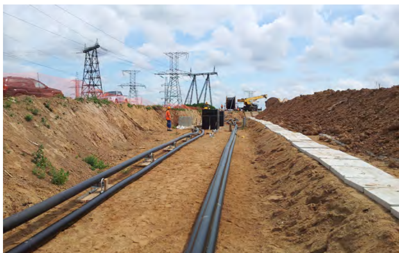
Рис. 23. Прокладка кабеля 500 кВ по линейным роликам на прямом участке трассы кабельной линии, а также кабели 500 кВ, уложенные после прокладки в треугольник вплотную
