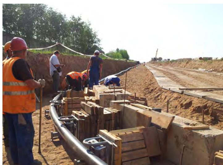
Рис. 22. Прокладка кабеля 500 кВ по угловым роликам на повороте трассы кабельной линии
