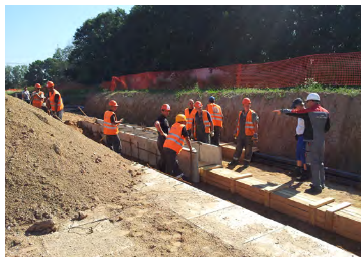
Рис. 25. Монтаж железобетонных плит, засыпка кабелей 500 кВ и плит песчано-гравийной смесью
