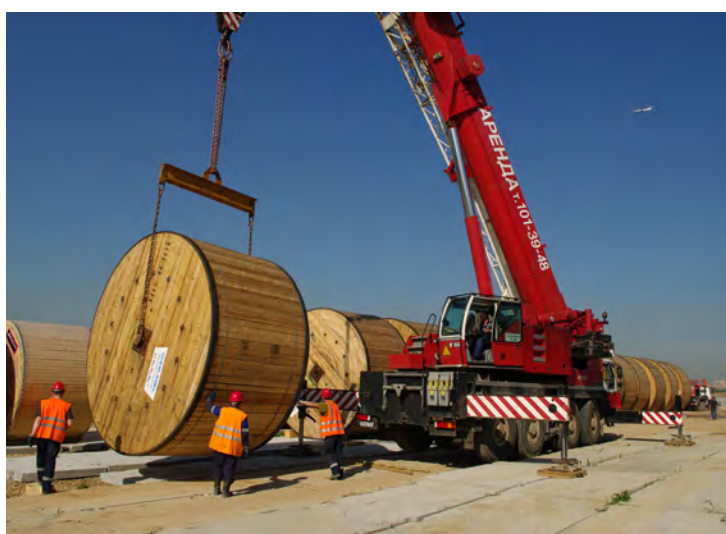
Рис. 19. Разгрузка барабанов с кабелем на площадку для хранения
