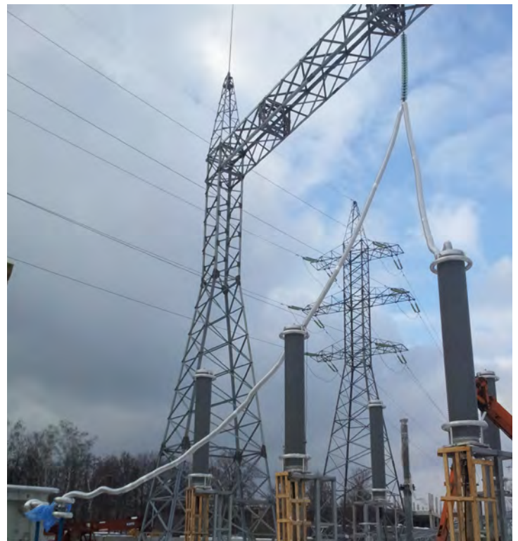
Рис. 33. Испытания концевых муфт на ВОПП на первом этапе строительства
