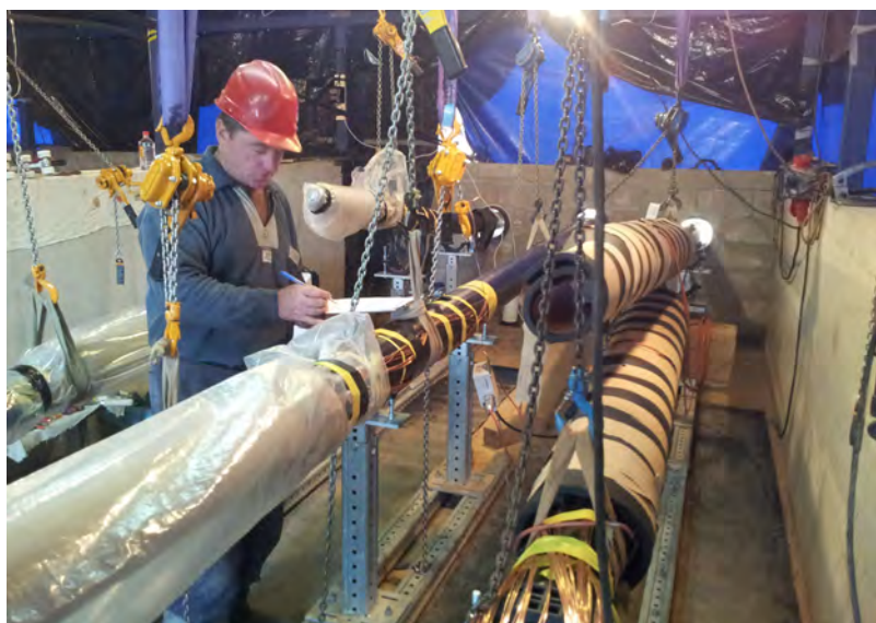
Рис. 28. Монтаж соединительных муфт SEHDVCB 550 в отапливаемом колодце, закрытом защитным тентом
